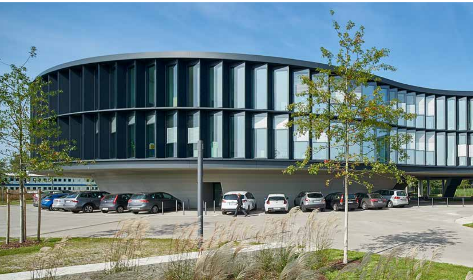
Штаб-квартира Обсерватории ESO с изделиями компании Hörmann (г. Гархинг под Мюнхеном)
